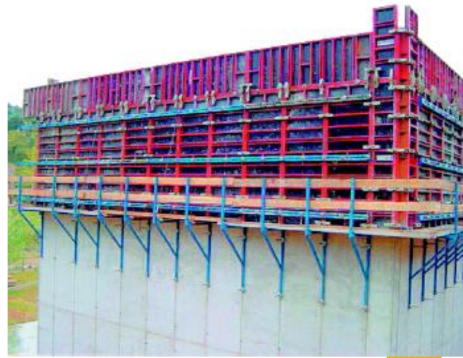
Realización de encofrados con ménsulas de trepado.
